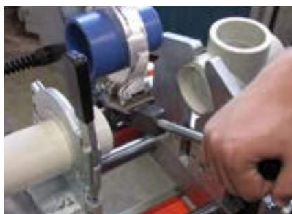
Ta isär delarna och lyft hastigt ur värmeplattan. 260°C oavsett material
